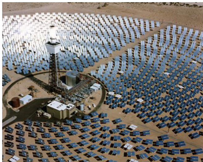
Hình 4.125. Nhà máy điện nhiệt mặt trời. 100MW ở Nam Phi
