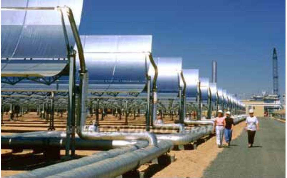
Hình 4.23. Hệ thống cung cấp nhiệt dùng gương phản xạ parabol trụ
