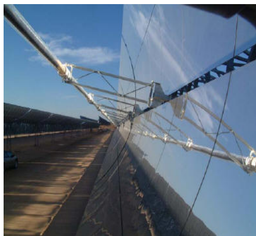
Hình 4.123. Collector parabol trụ
