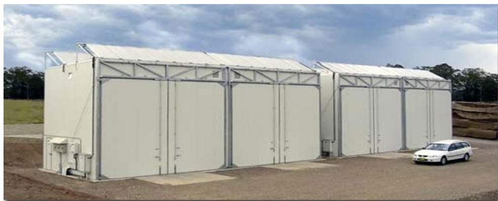
Hình 4.82. Hệ thống sấy gỗ dùng năng lượng mặt trời và Gas ở Australia.
