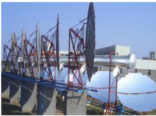
Hình 4.19 Hệ thống cấp hơi nước dùng gương Parabol tròn xoay
